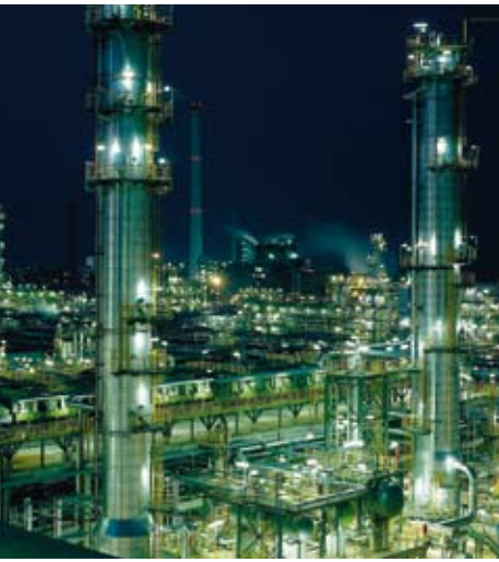
Enfriadores de aire con aspas instalados en la refinería Total en Mitteldeutschland, Alemania
