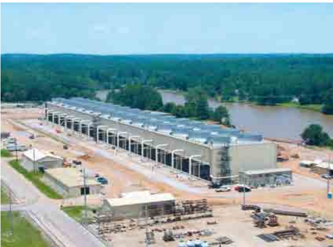
Torre de enfriamiento
